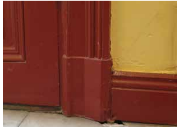
Foder, fodersocklar och golvsöcklar är original i trapphus.
