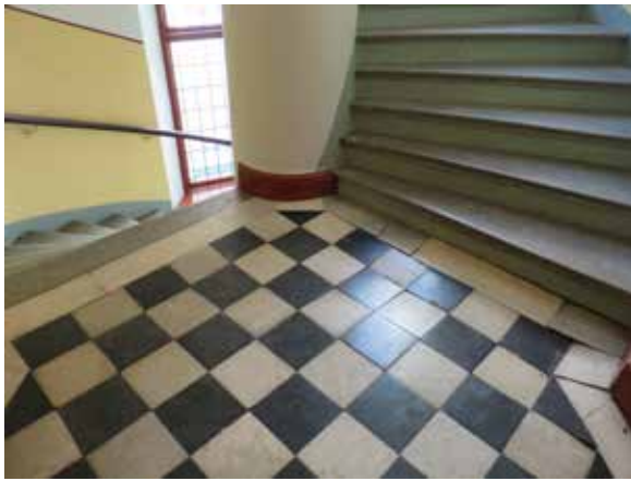
Gathusets golv består av svarta plattor belgisk kalksten och vita plattor i carraramarmor.
