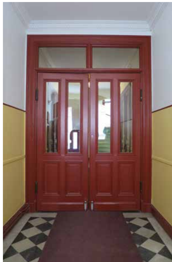
Mellandörrarna är ursprungliga, glasade och med profilerade speglar. På väggen syns den övermålad mittbandslisten.
