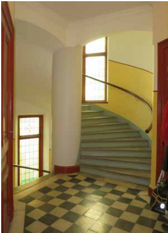
I gathusets trapphus finns fönster med äkta blyglasinfattningar. Även beslagen, hasp och hake är ursprungliga.
