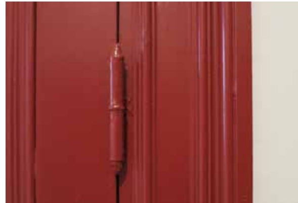
Ursprungliga gångjärn visar att lägenhetsdörren är i originalutförande.
