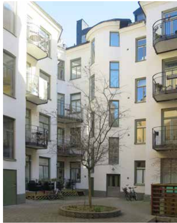
Mot gården syns hur trapphusets fönster följer trapploppets stigning.
