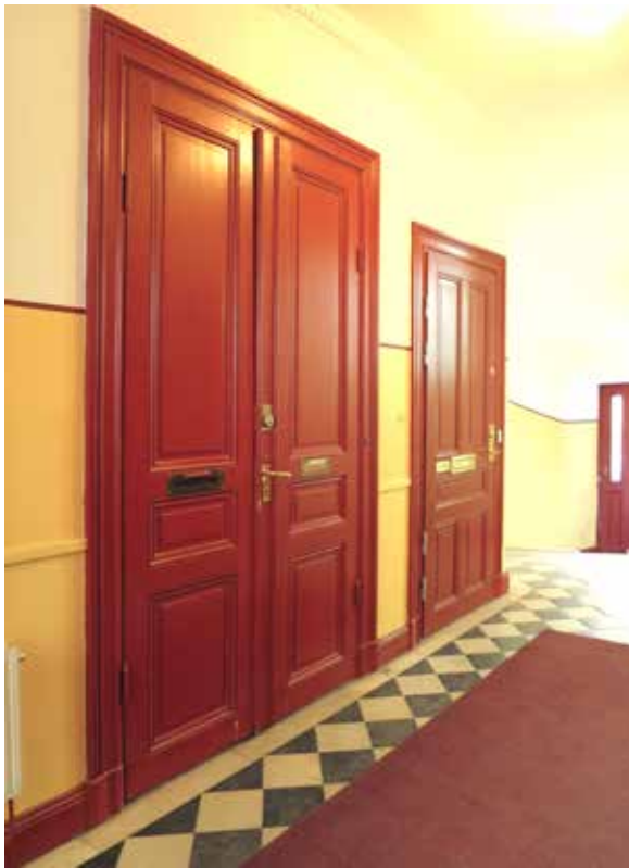
I gathuset har varje lägenhet två ingångar. En pardörr som huvudentré och en köksdörr.
